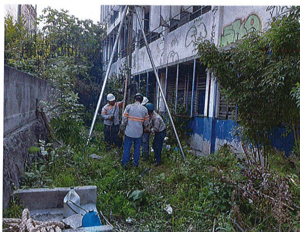
Fotografía N°1: Mostrando ubicación y ejecución en proceso del Sondeo S-1.
