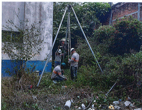
Fotografía N°2: Mostrando ejecución en proceso del Sondeo S-2 en zona del fondo del Edificio.
